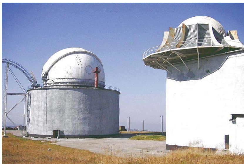
Фото 2. Оптико-электронные средства СККП в составе комплекса «Крона»
